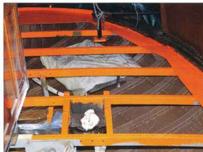
Här syns fördäckets styrbordsida när det gamla däck var bortrivet. Däckbalkar och stringerplåtar är nymålade. Foto Åke Karlsson 26 november 2011
