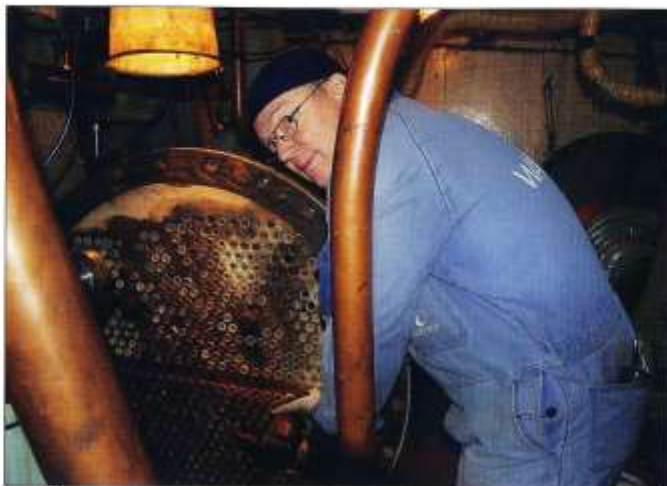
Jan Amörntson demonterar tuber i kondensorn. Ett tålmodigtprövande arbete i det tränga utrymmet för och åter om kondensorn. Foto Bo Starmark 17 november 2011
