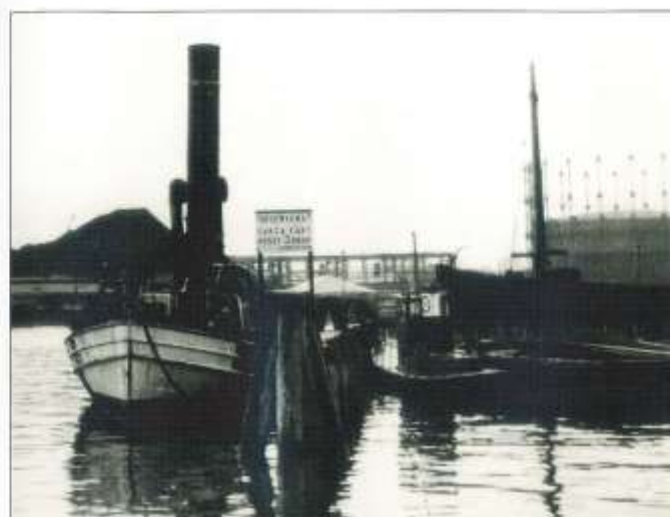
Göta vid pålverket vid Ringön i Göteborg efter branden. Foto Dag Almqvist i september 1951
